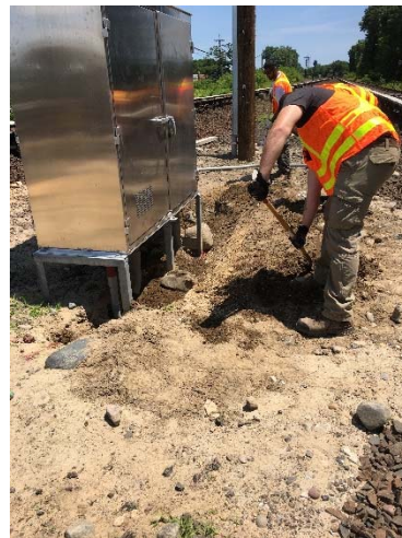
C-Case Conduit Installation
