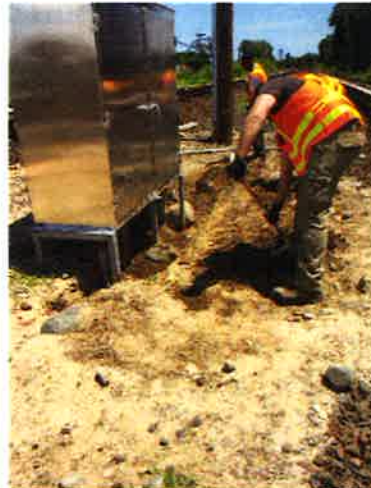
C-Case Conduit Installation
