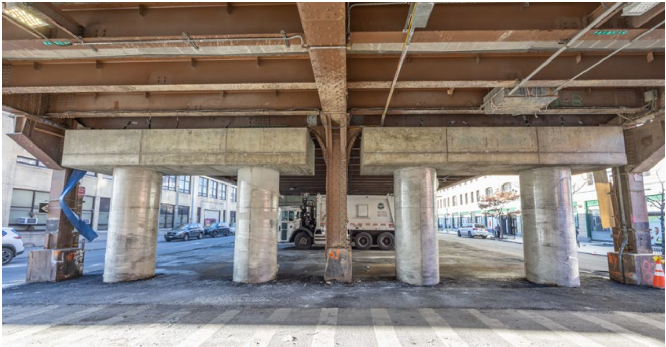
Nuevos cimientos, columnas y remates de pilares entre las calles 130 Este y 131 Este
