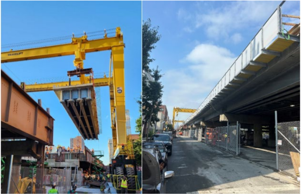
Pórtico colocando la primera unidad de puente prefabricado. Nuevo viaducto visto desde la calle (r.)
