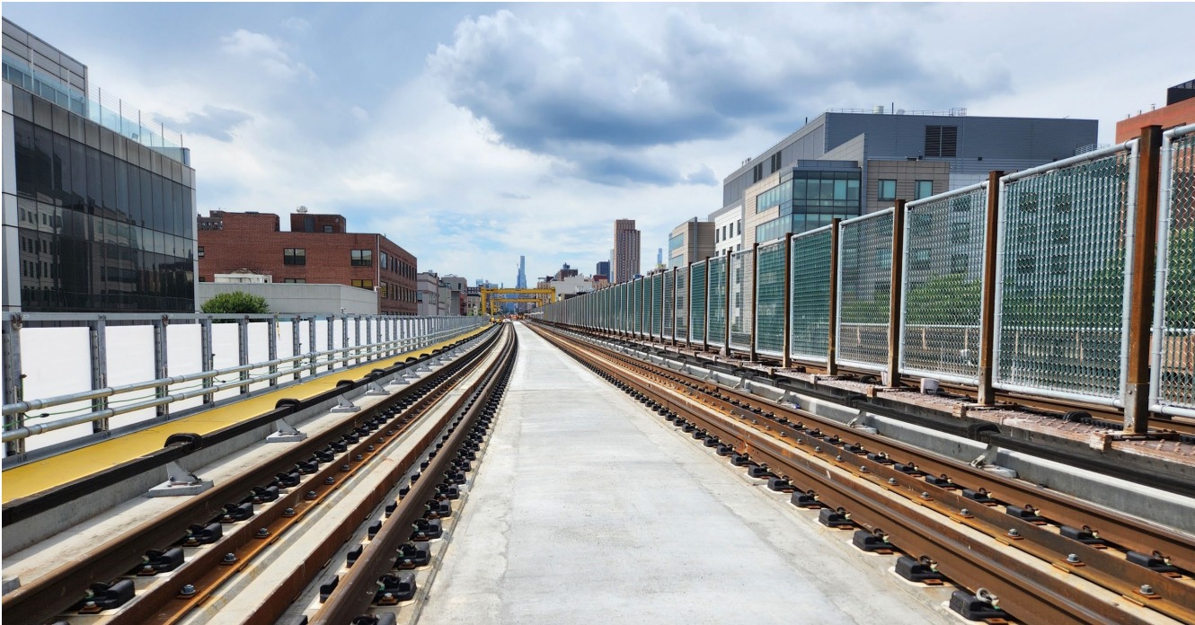
Vista a nivel de vía de las sustituciones finalizadas en las vías 3 y 1
