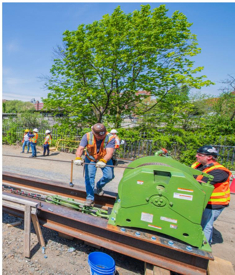
*Cuadrillas usando un cabrestante neumático para lanzar el puente sobre el río Bronx, mayo de 2025*
