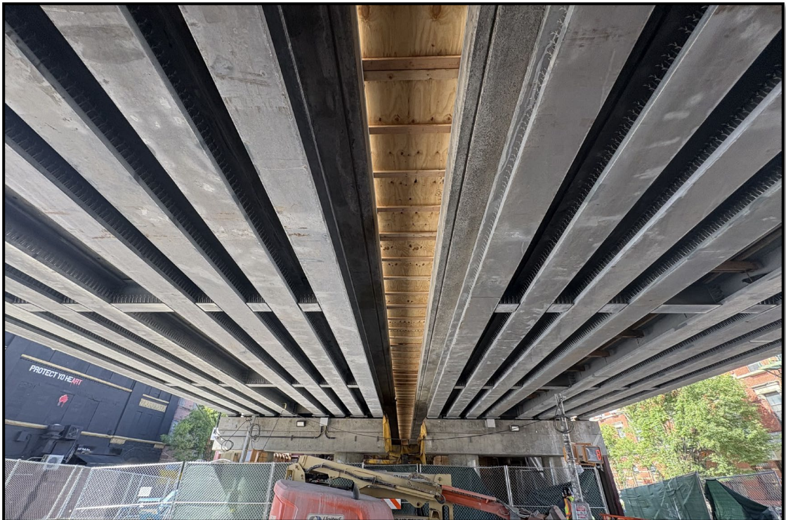
Parte inferior del nuevo viaducto de Park Avenue
