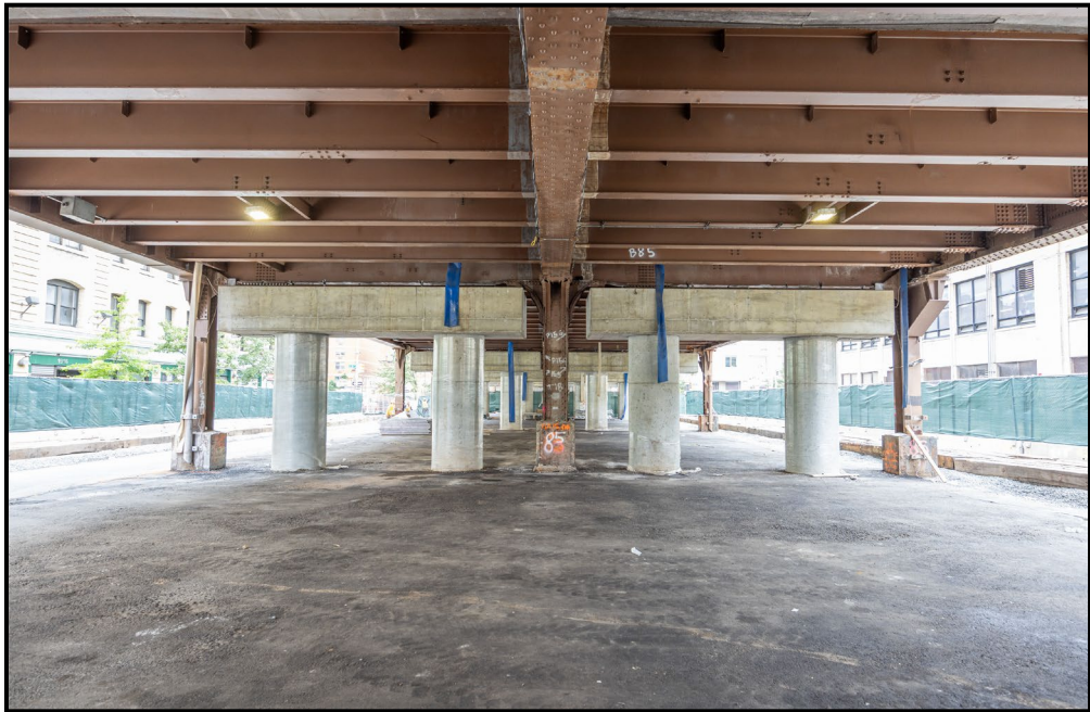
Terreno terminado bajo el viaducto entre las calles 130 Este y 131 Este
