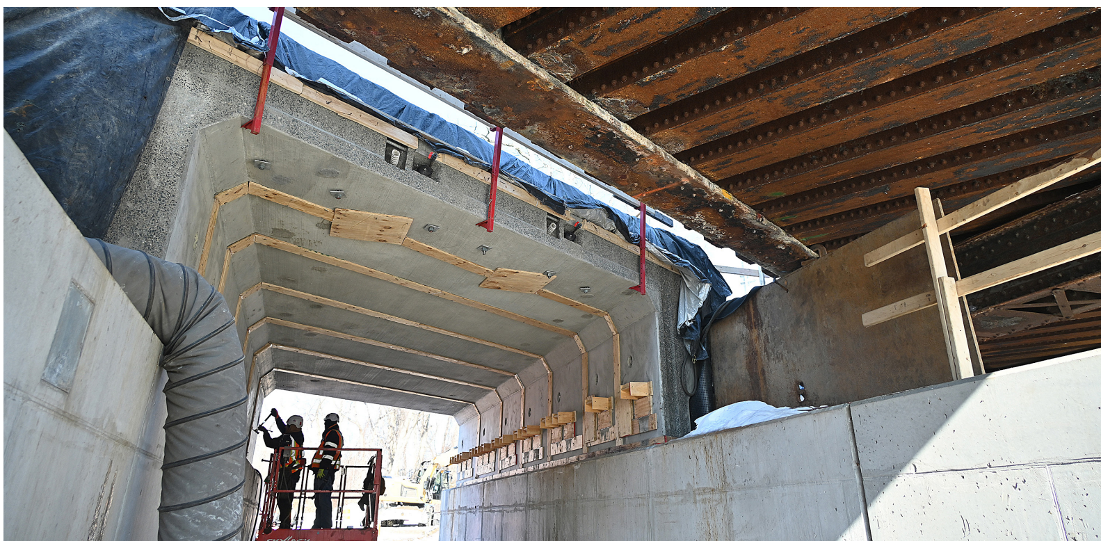
Subestructura moldeada in situ y superestructura prefabricada para el nuevo Pelham Lane Bridge, enero de 2026
