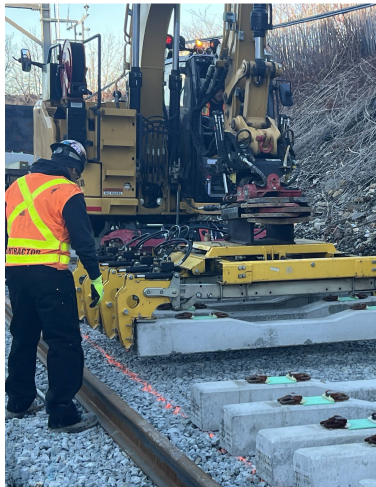
Colocación de vías cerca de Parkchester Van-Nest, enero de 2026.
