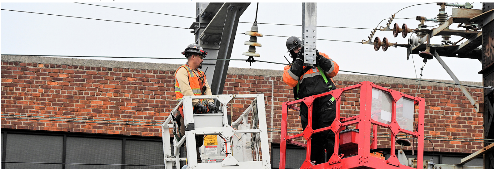
Tendido de cables en la subestación Parkchester Van-Nest, enero de 2026.
