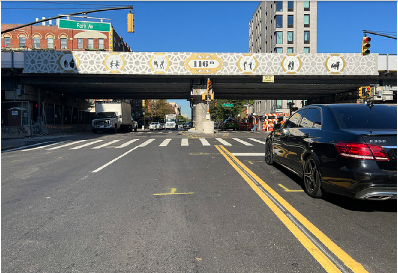
Instalación artística en la calle 116 Este
