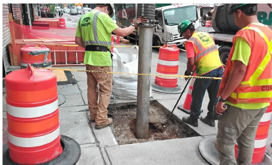
Pozos de prueba de servicios públicos en la acera de la 2ª Avenida
