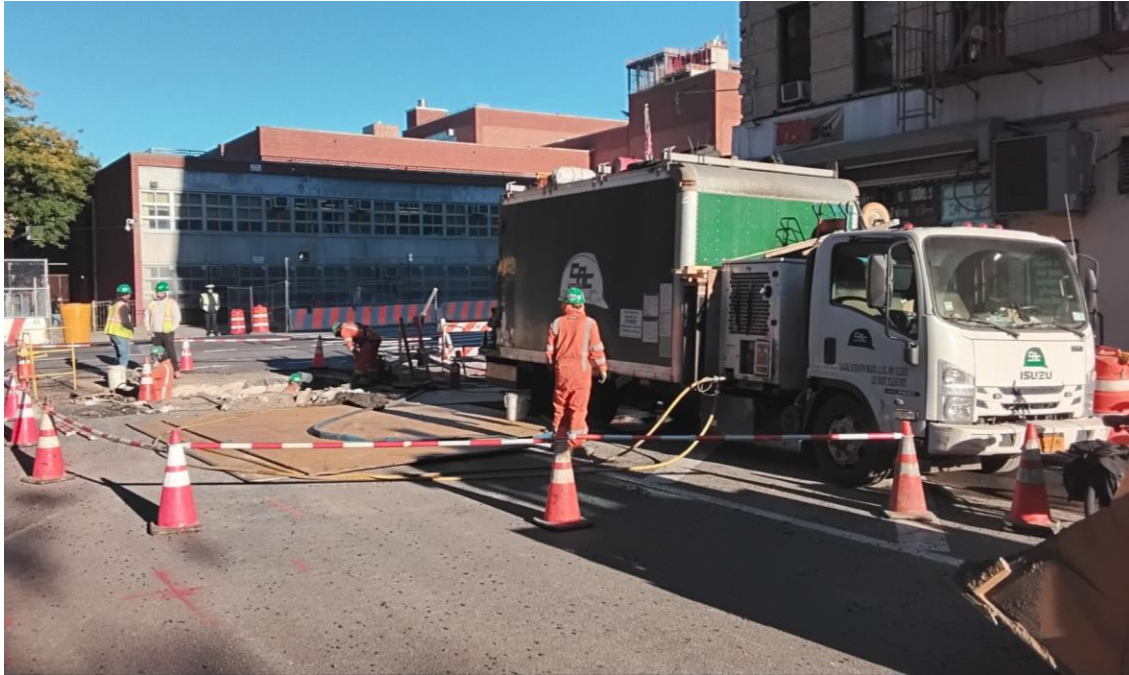
Electrical Conduit Installation
