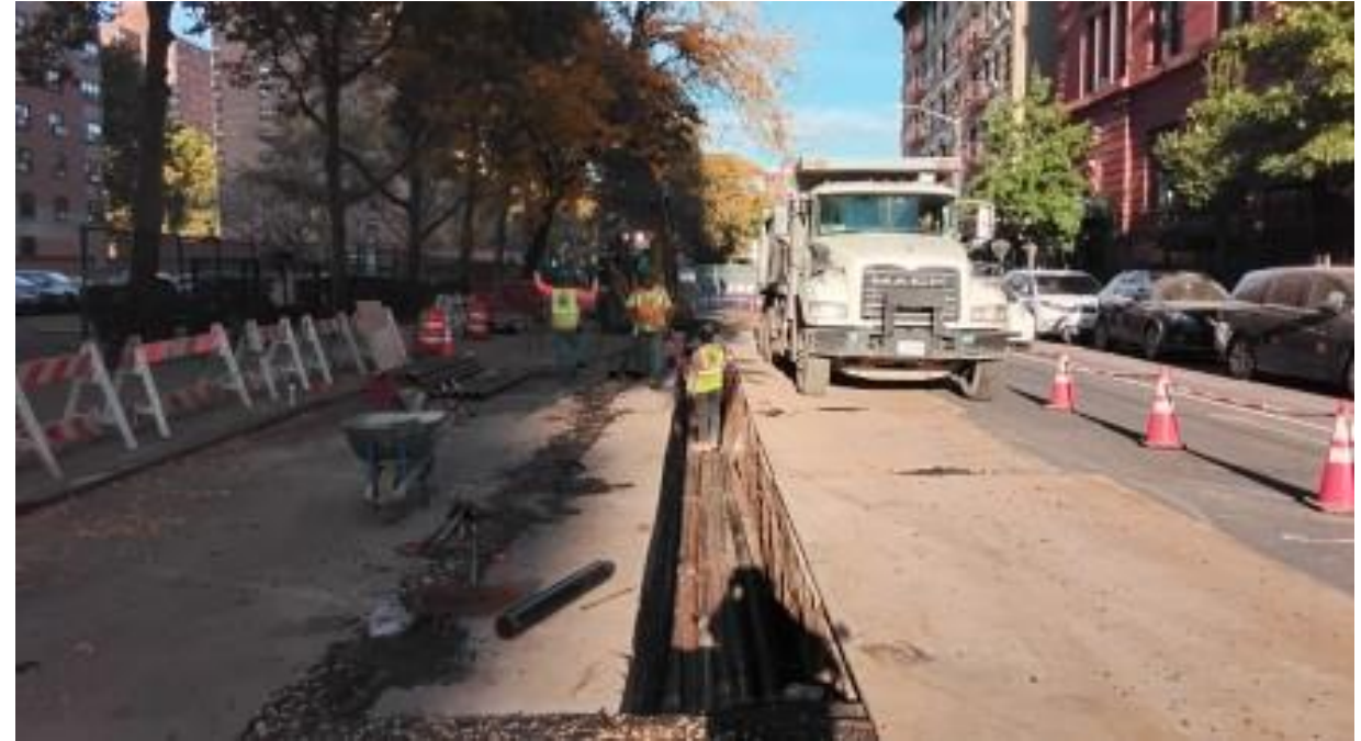
Electrical Conduit Installation
