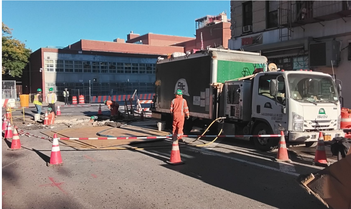
Electrical Conduit Installation
