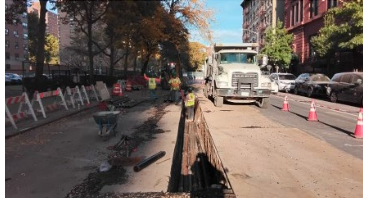
Electrical Conduit Installation
