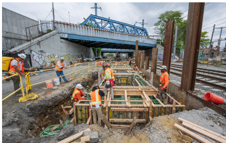
Instalación de encofrado para el vaciado de concreto, mayo del 2026
